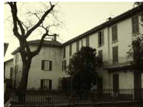
Veduta di Casa Corbetta
